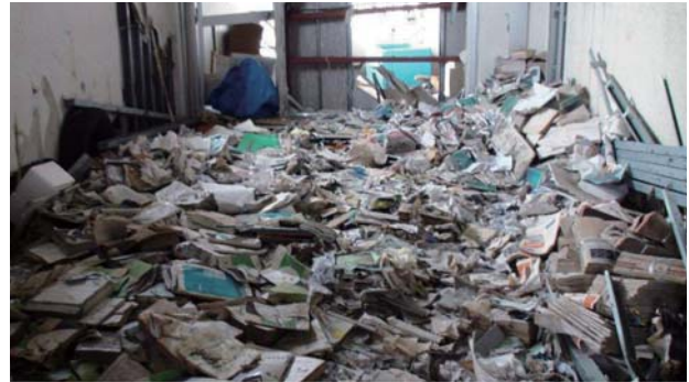
図7. 図書室。スチール製本棚を撤去した状態。大量の書籍が水浸しの状態で散乱していた。
