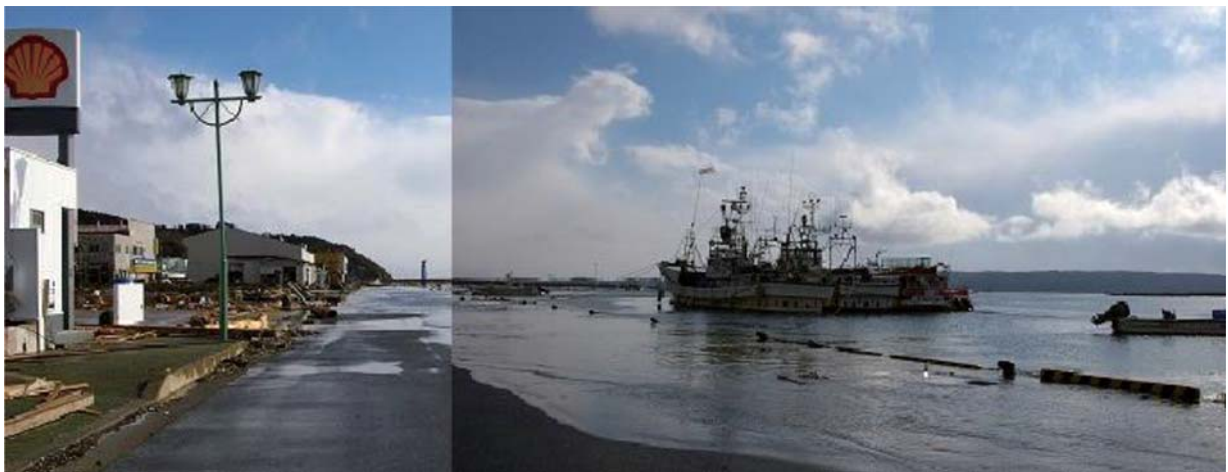
図2. 鮎川実験場（左側街灯の背面の建物）とその海側の岸壁。この大地震により1.2 m地盤沈下し、満潮時には岸壁一帯が水没している。この写真でも岸壁の上まで海水が押し寄せているのがわかる。（石巻市役所及川伸悦氏撮影）
