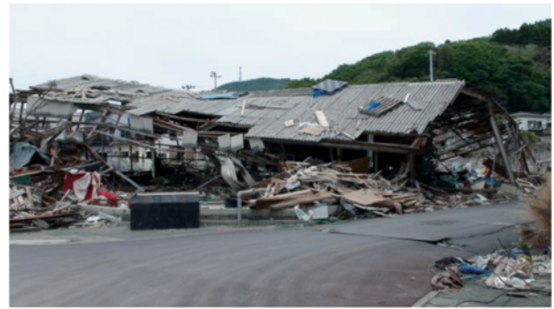
図1. 被災した鮎川の様子。
